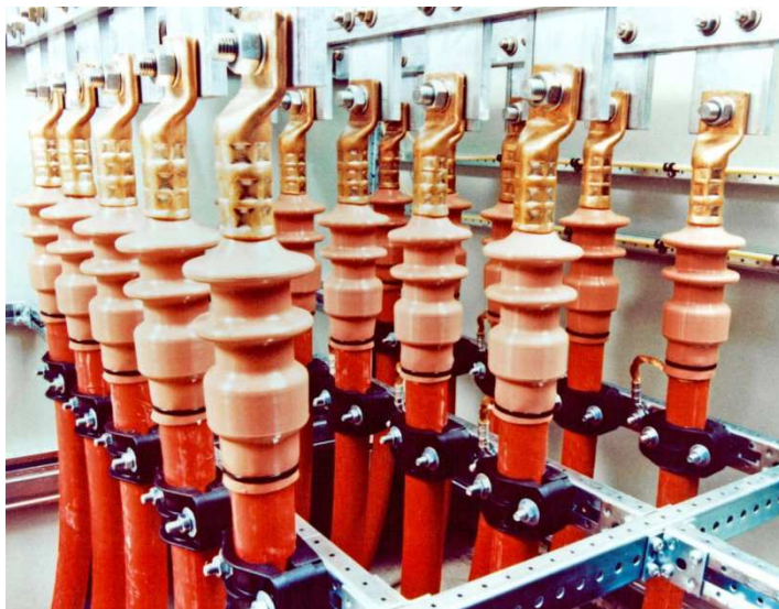
Switch gear connection Serie K
